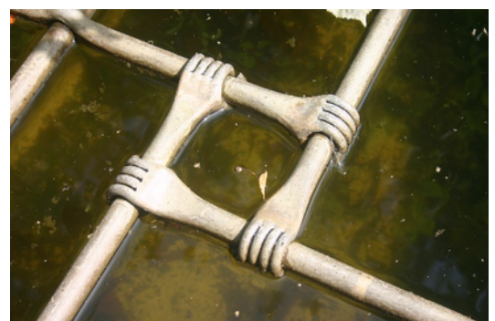
Gitter des Täuferbrunnens in Hörbach
